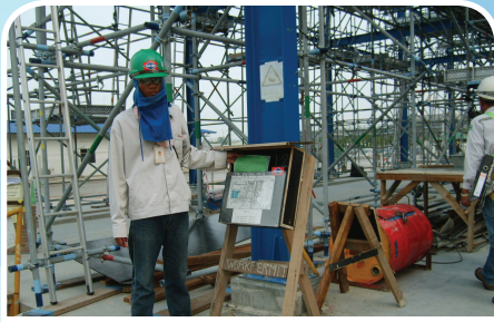
การตรวจสอบใบ Work Permit โดย จป.
