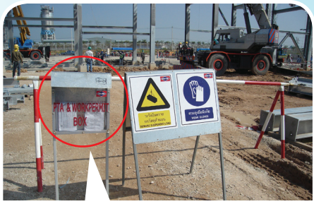
การติดตั้งใบ Work Permit บริเวณจุดทำงาน
