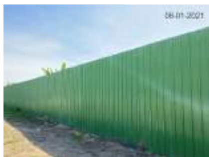
ภาพข้อกำหนดด้านเสียง, กำแพงกันเสียงชั่วคราวบริเวณพื้นที่ก่อสร้าง และการตรวจวัดเสียงตามข้อกำหนด
