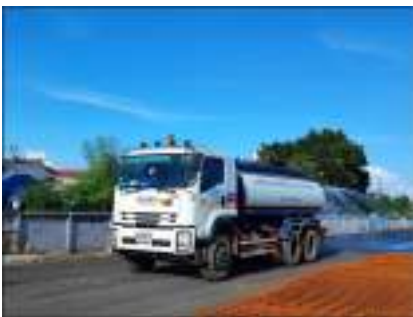
ภาพการฉีดพรมน้ำเพื่อลดการฟุ้งกระจายของฝุ่นละออง, การจำกัดความเร็วของรถและการทำความสะอาดล้อรถก่อนออกนอกพื้นที่ก่อสร้าง
