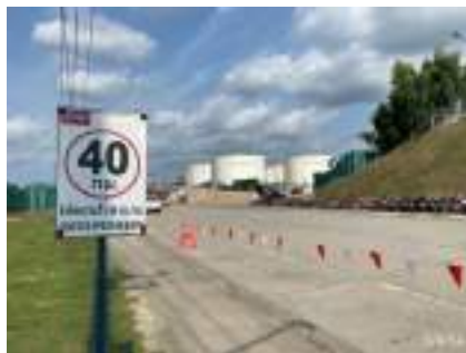
ภาพการฉีดพรมน้ำเพื่อลดการฟุ้งกระจายของฝุ่นละออง, การจำกัดความเร็วของรถและการทำความสะอาดล้อรถก่อนออกนอกพื้นที่ก่อสร้าง
