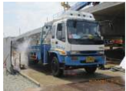
ภาพการฉีดพรมน้ำเพื่อลดการฟุ้งกระจายของฝุ่นละออง, การจำกัดความเร็วของรถและการทำความสะอาดล้อรถก่อนออกนอกพื้นที่ก่อสร้าง
