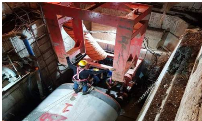
ดันท่อรวบรวมน้ำเสีย ด้วยวิธี Pipe Jacking
