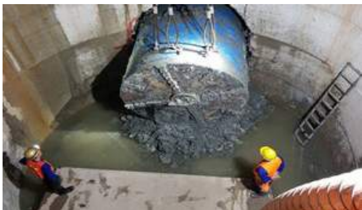
ดันท่อรวบรวมน้ำเสีย ด้วยวิธี Pipe Jacking
