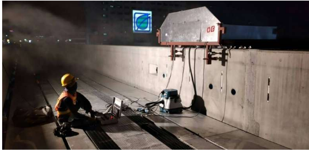
เครื่องเจียรราง Guide way beam
