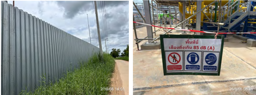
รูปภาพ การติดตั้งกำแพงกันเสียงและป้ายเตือนกรณีเสียงดัง
