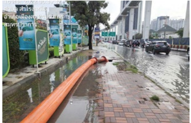
การลอกท่อน้ำทิ้งในช่วงฤดูฝน เพื่อลดการท่วมขังของปริมาณน้ำในชุมชนที่มีน้ำท่วมขัง
