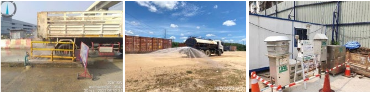
การทำมาสะอาดล้อรถก่อนออกนอกพื้นที่ก่อสร้าง การฉีดพรมน้ำเพื่อลดการฟุ้งกระจายของฝุ่นละออง และการตรวจวัดคุณภาพอากาศภายในพื้นที่โครงการก่อสร้าง
