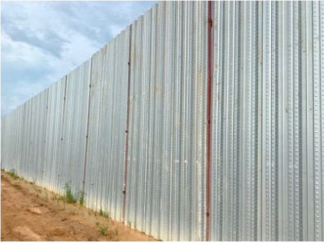
กำแพงกันเสียงชั่วคราวและการตรวจสอบดูแลบำรุงรักษา และซ่อมแซมเครื่องมือ และอุปกรณ์ให้อยู่ในสภาพดี
