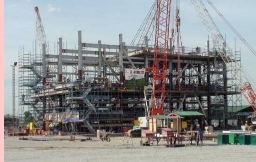
Modules Fabrication for Pluto LNG Plant 5,069 THBmn, STP&I
