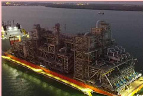
Ichthys LNG Module STP&I
