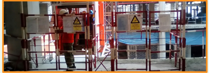
จัดทำรั้วกันลิฟต์ทุกชั้นเพื่อป้องกันการพลัดตก
