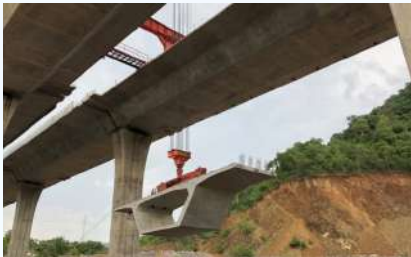
รูปที่ 1 SEGMENTAL BOX GIRDER ในโครงการทางหลวงพิเศษระหว่างเมือง บางปะอิน-โคราช
