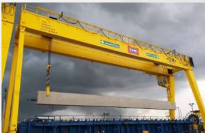
รูปที่ 2 อุปกรณ์ยกทางรถไฟ คอนกรีตอัดแรงของโครงการรถไฟฟ้ามหานคร สายสีชมพูและสีเหลือง
