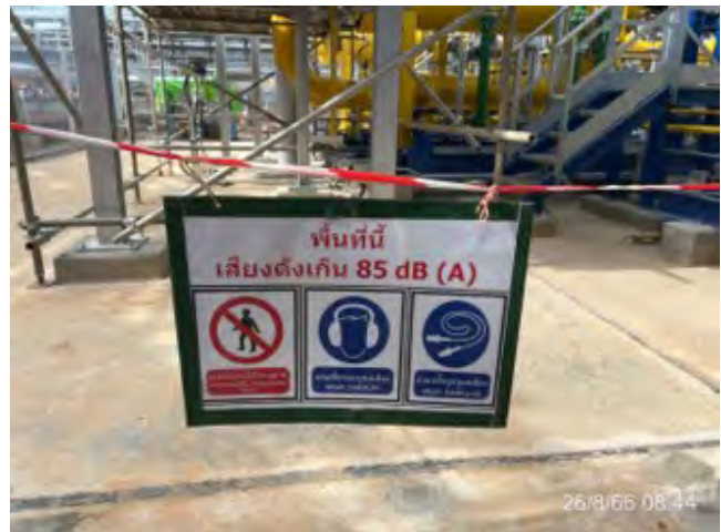
รูปการติดตั้งกำแพงกันเสียงและป้ายเตือนกรณีเสียงดัง
