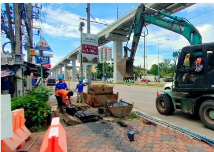
การลอกท่อน้ำทิ้งในช่วงฤดูฝน เพื่อลดการท่วมขังของปริมาณน้ำในชุมชนที่มีน้ำท่วมขัง
